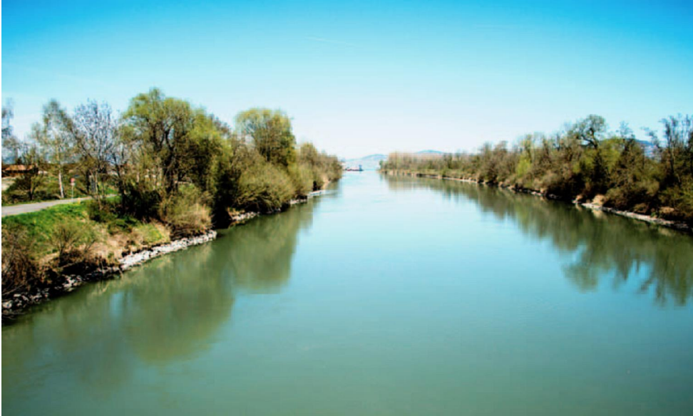
Au Bouveret, un peu plus d'un kilomètre de digue doit être consolidé, de la passerelle piétonne sur le Rhône jusqu'à l'embouchure, pour protéger les habitations situées immédiatement au pied de l'ouvrage. Les travaux sont chiffrés à trois millions. CHRISTIAN HOFMANN
