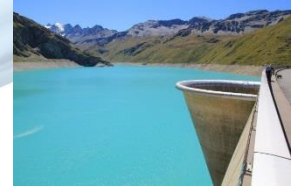
Barrage de Moiry - 1958
