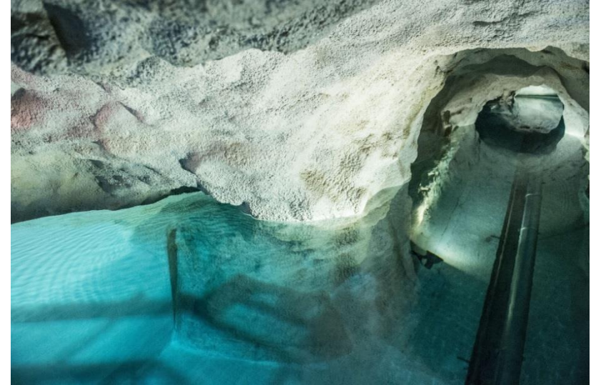
Réservoir d'eau potable de Sion
